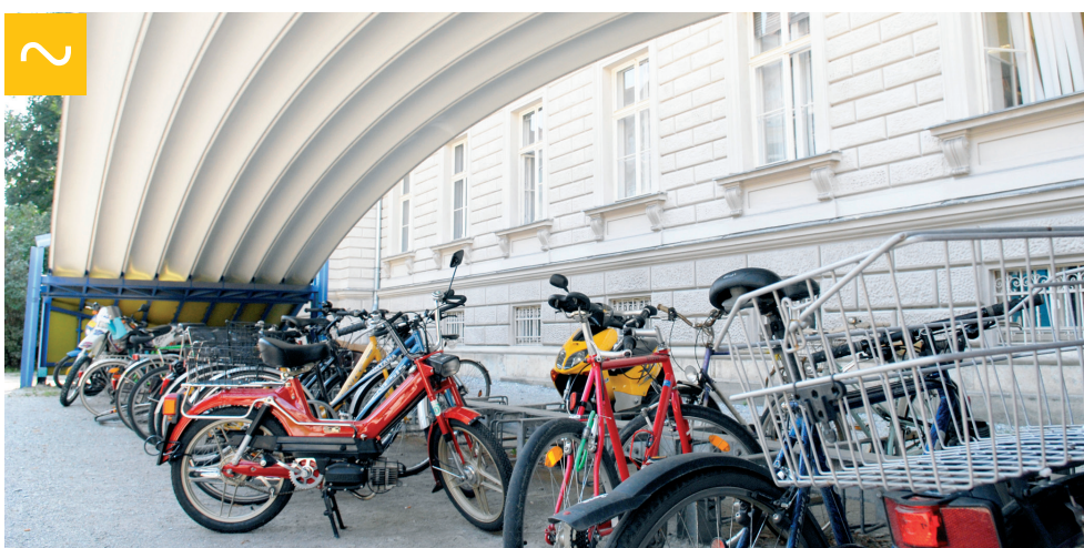
Überdachte Fahrradabstellanlage vor einem Universitätsgebäude. Die Vorderradhalter erfüllen jedoch nicht die Anforderungen einer hochwertigen Anlage.
