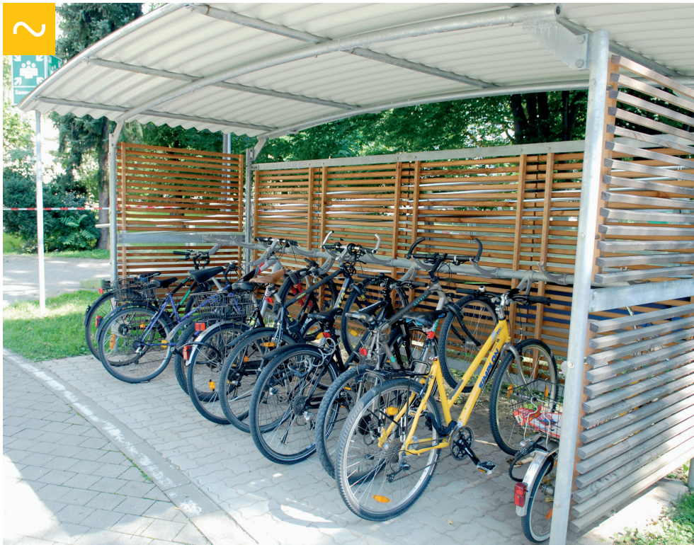
Vorbildlich überdachte Fahrradabstellanlage vor der TU Graz. Die eingesetzten Lenkerhalter bieten jedoch keine optimale Ansperrmöglichkeit.
