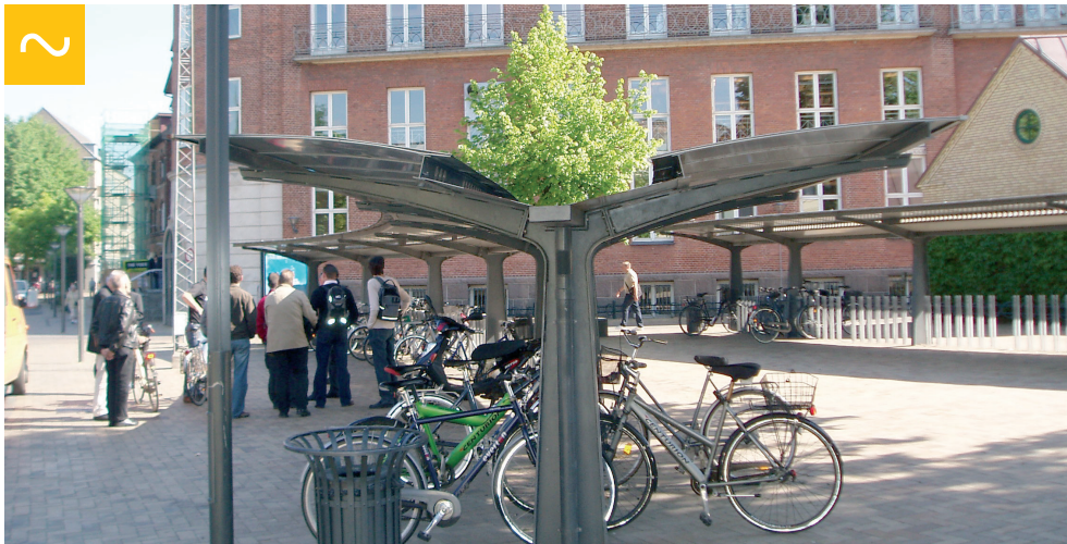
Anspruchsvolle Überdachung einer Fahrradabstellanlage im innerstädtischen Bereich. Leider wurde hier nur ein Vorderradhalter installiert.
